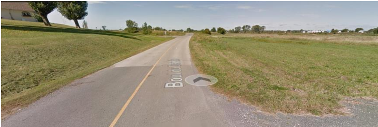
Figure 22. Illustration de la technique de bétonnage de la route © Google Maps
